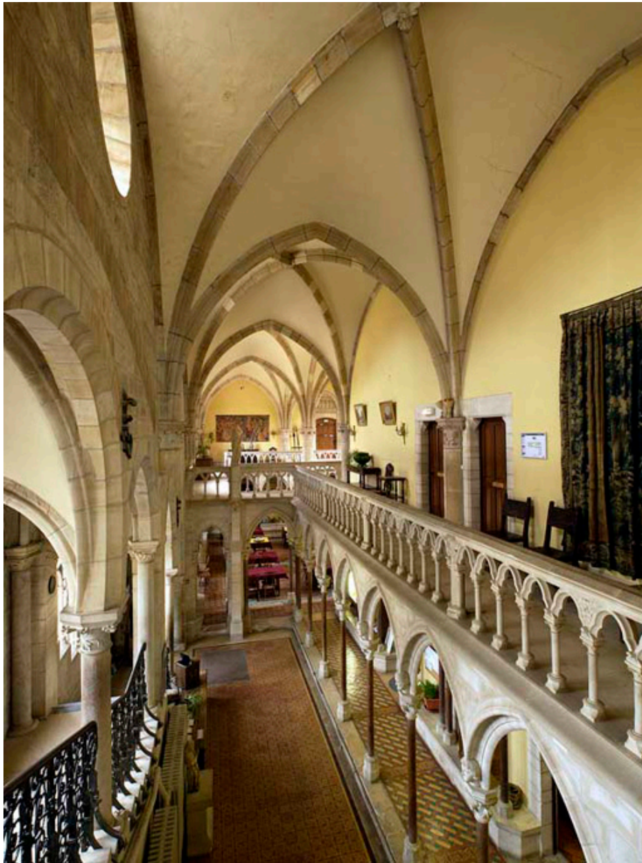
Bâtiment du réfectoire : partie sud du bâtiment (aménagement néo-gothique) : galeries basse et haute, et vestibule (vue prise depuis le sud).
