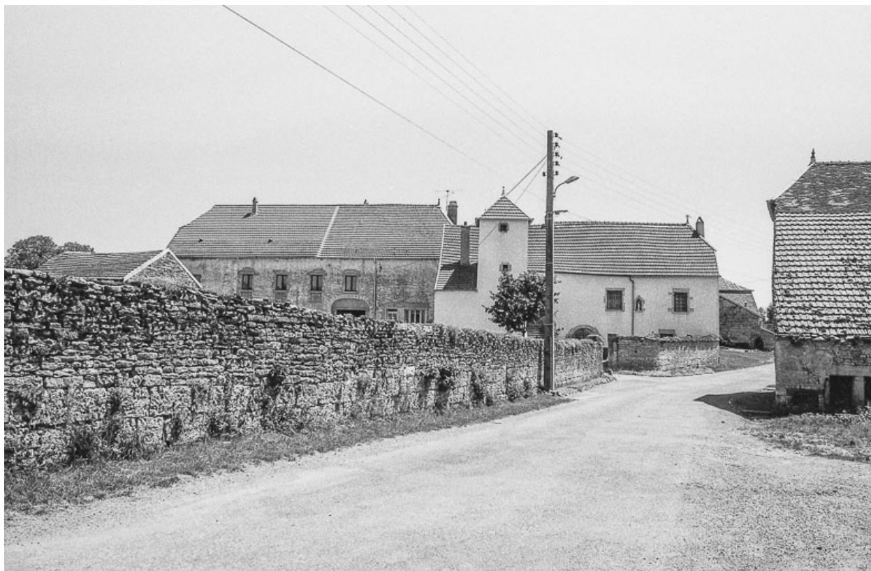
Vue éloignée du bâtiment depuis la rue.
