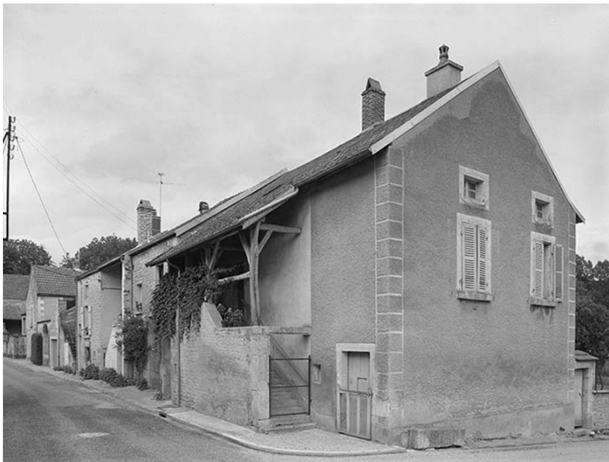
Façades à l'angle de l'impasse.
