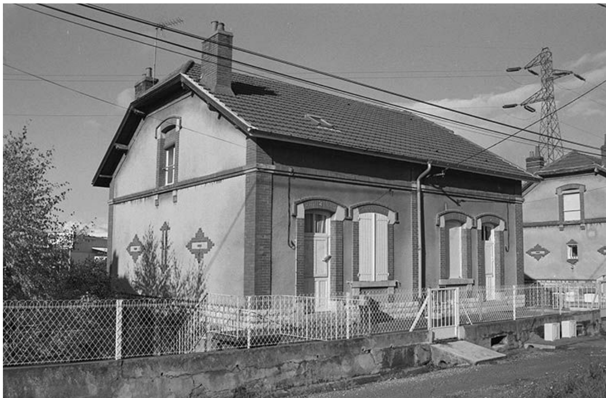
Bâtiment à deux logements ouvriers de " type 4 ".
