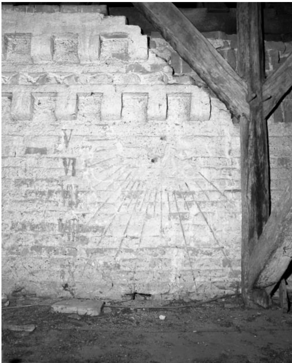
Comble de la chapelle droite : cadran solaire.
