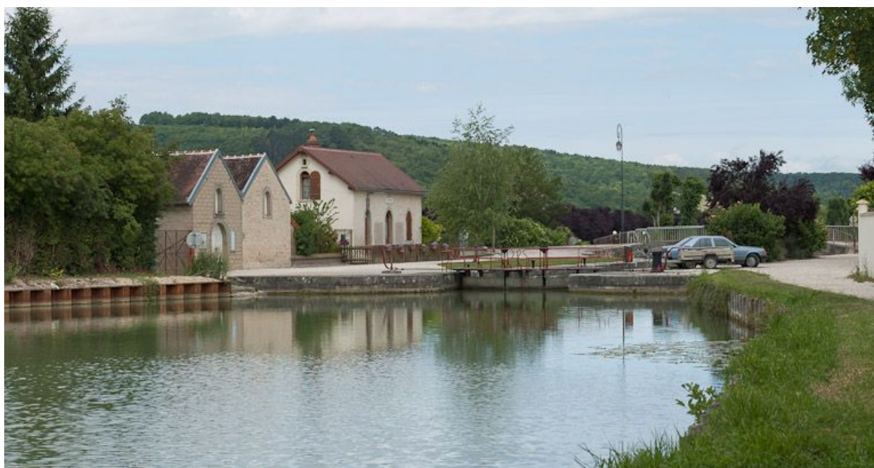
Vue du site d'écluse depuis l'amont.
