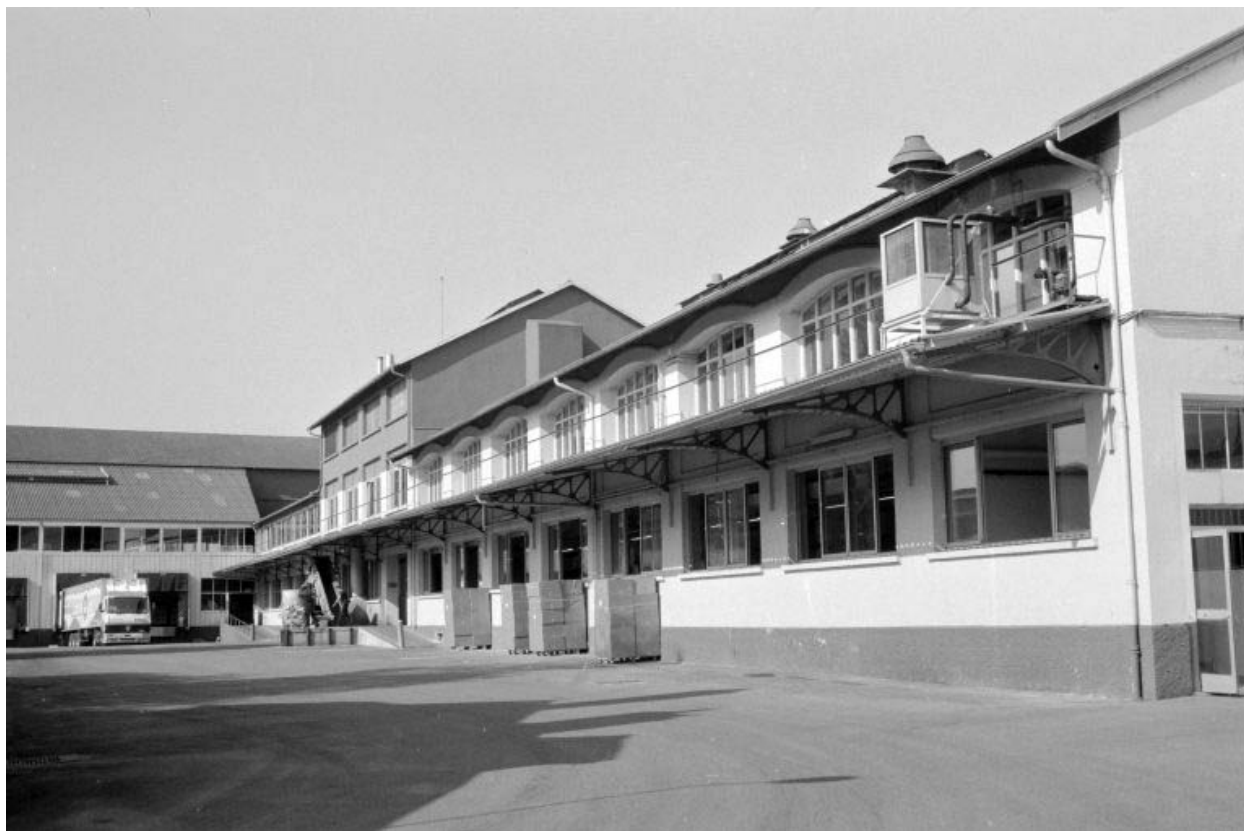
Atelier de fabrication (E, F, G), depuis l'est.
