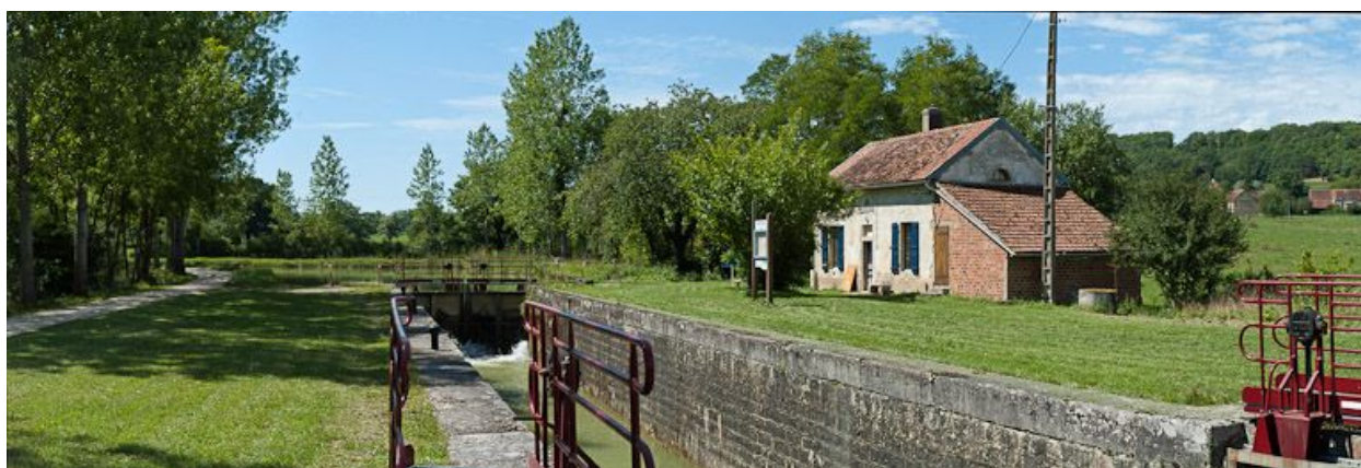
Vue d'ensemble du site d'écluse.
