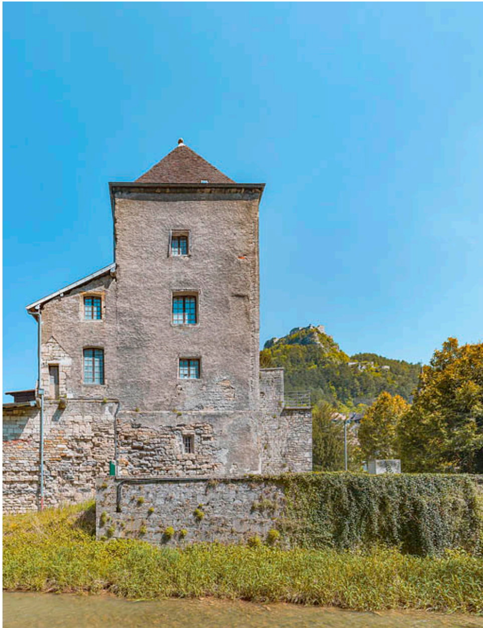
Façade ouest de la tour de Reculot.
