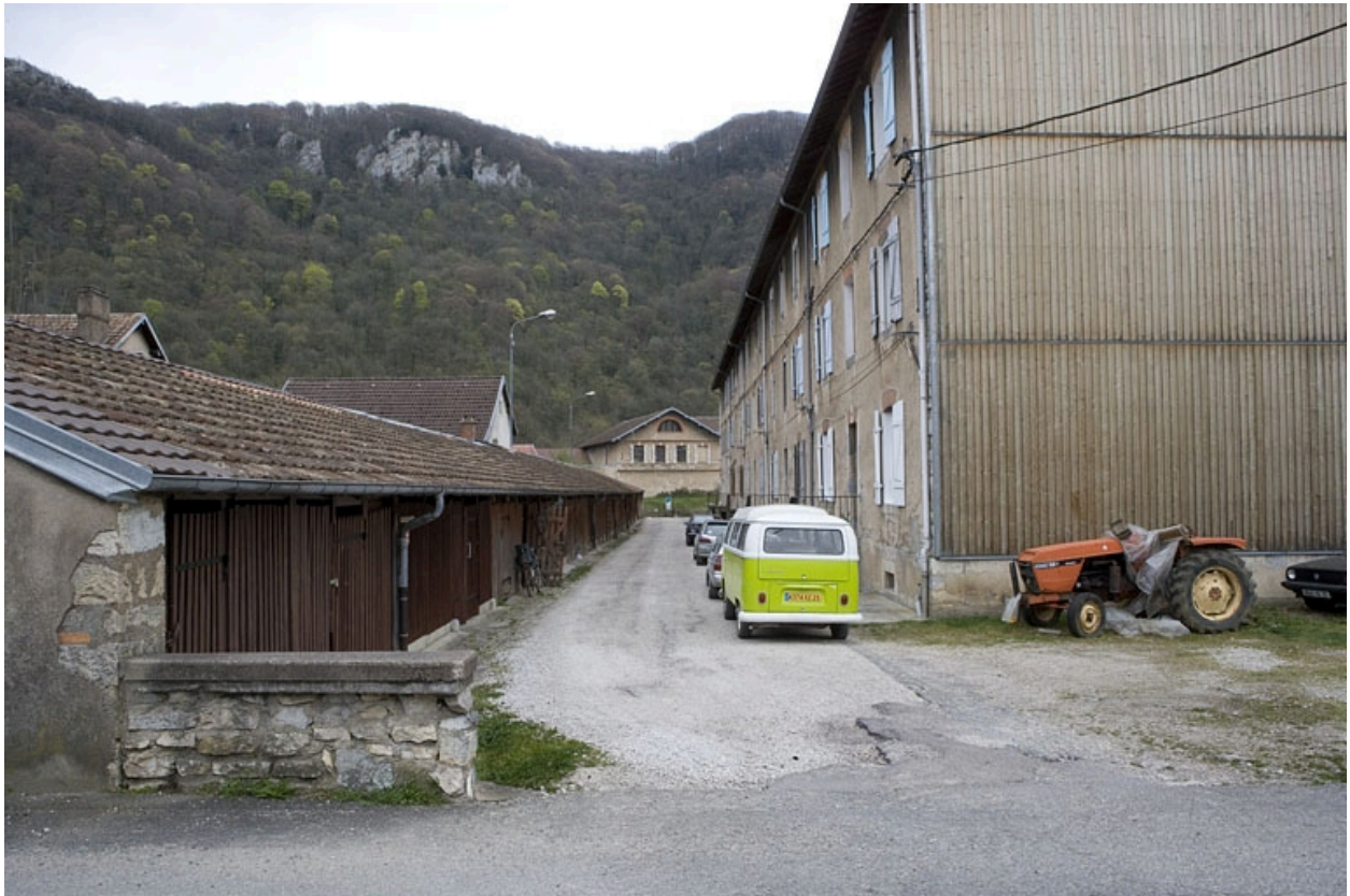
Logement d'ouvriers (10 à 16 rue des Ecoles). Façade nord et bûcher.
