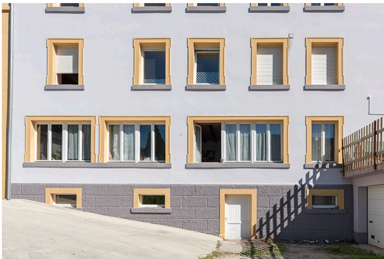
Façade postérieure : baies d'atelier.
