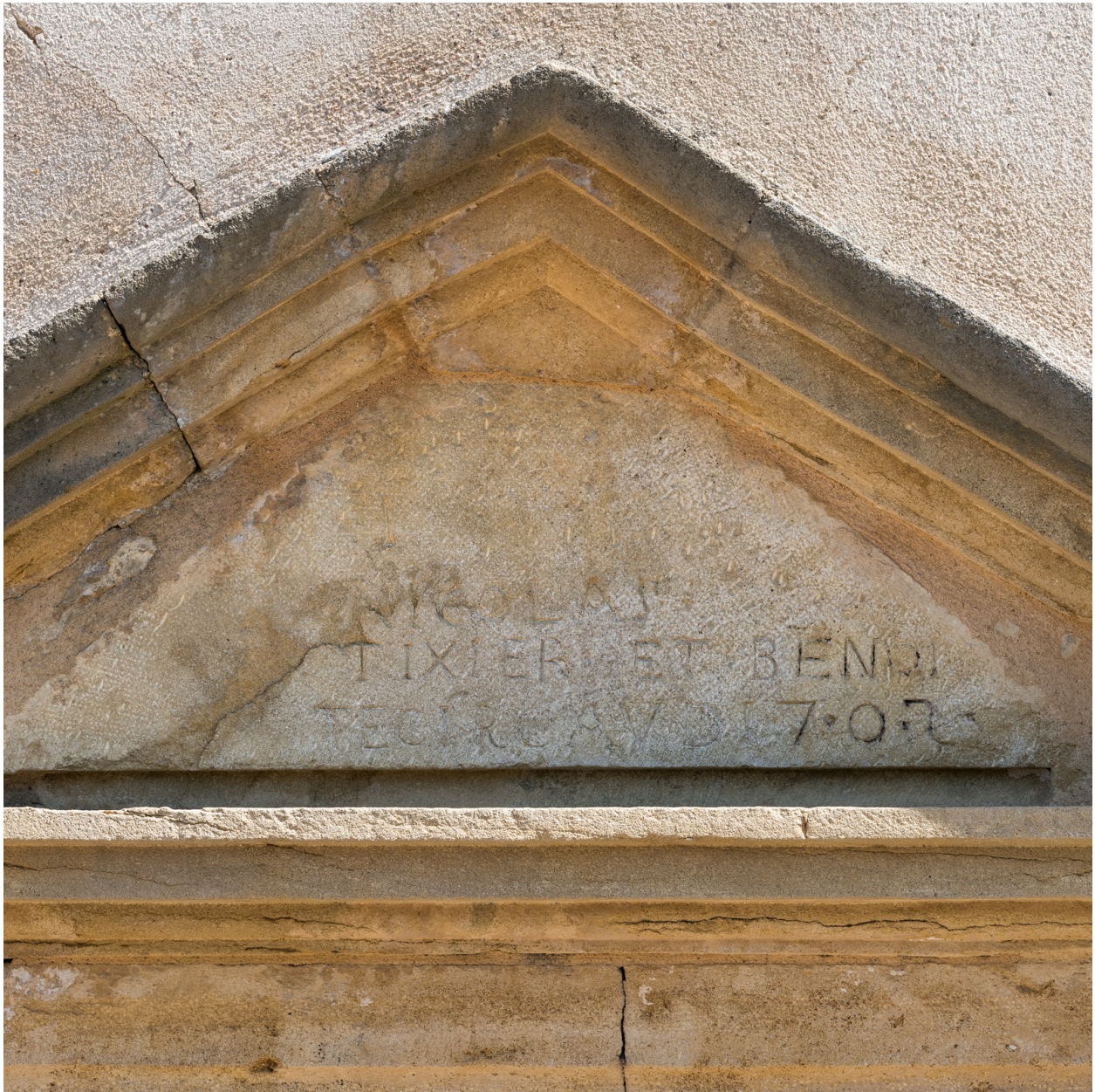
Fronton triangulaire surmontant la porte d'entrée : vue de détail de l'inscription.
