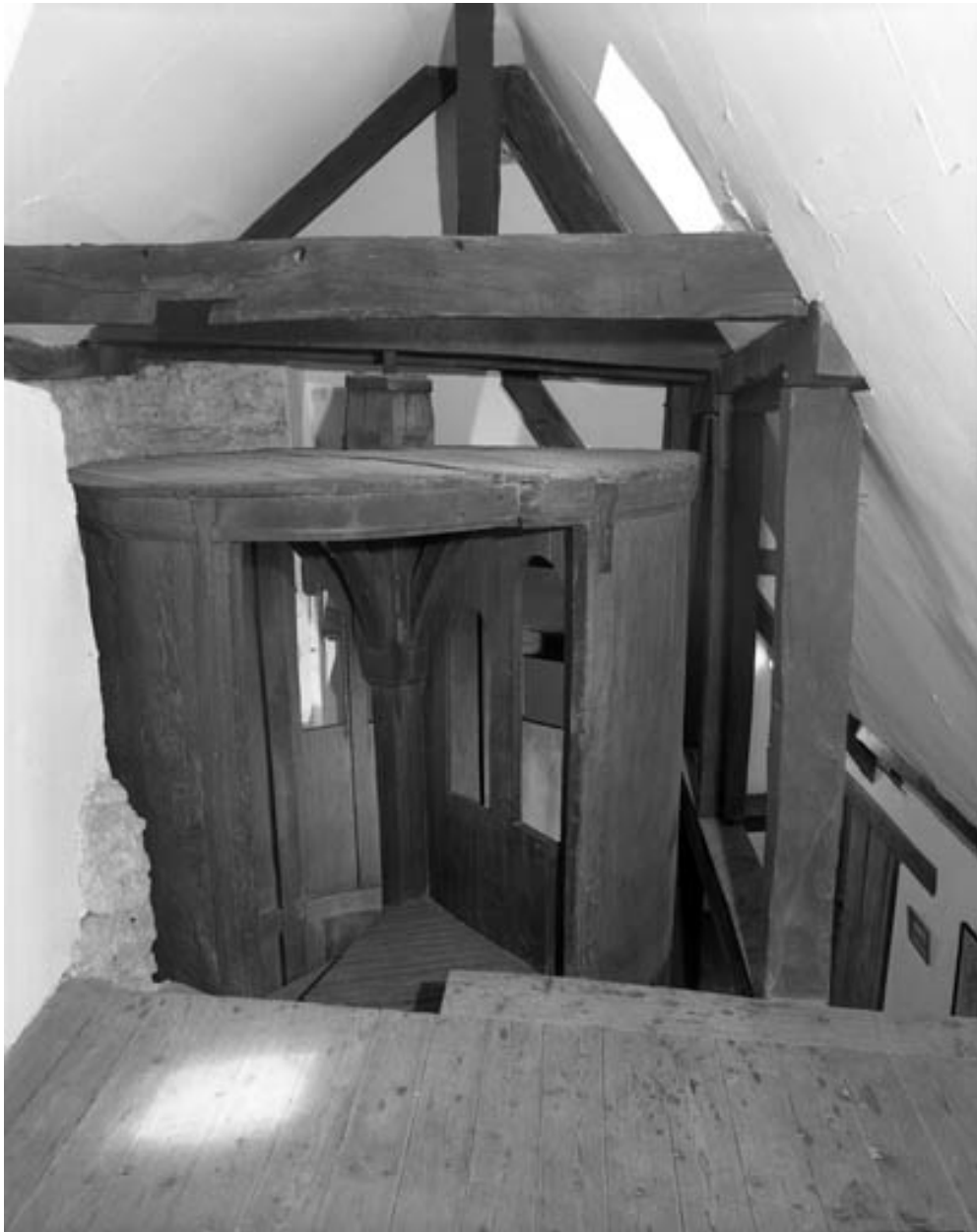
Sommet du cylindre depuis les combles avec le détail de la partie supérieure du noyau de l'escalier.
