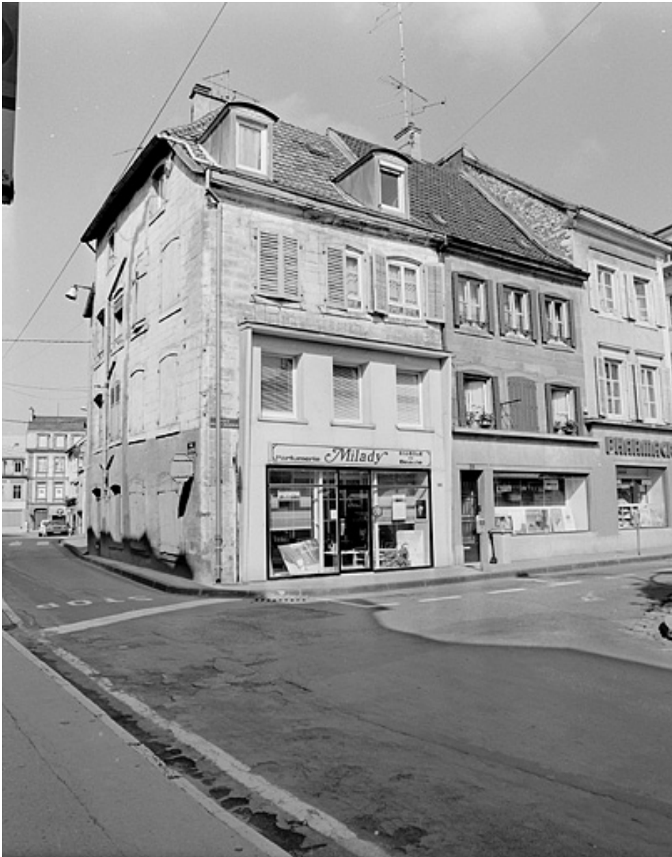
Vue d'ensemble à l'angle de la place Denfert-Rochereau et de la rue Saint-Hippolyte.
