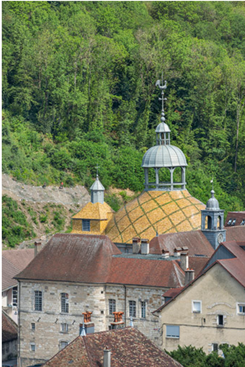
Vue plongeante depuis le sud-est.
