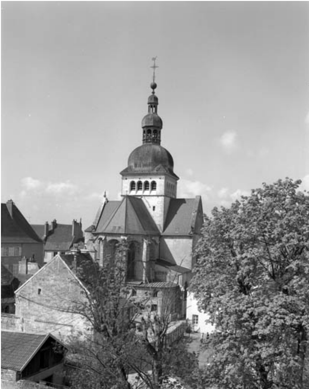
Vue éloignée du chevet depuis le sommet de la tour du Paravis.
