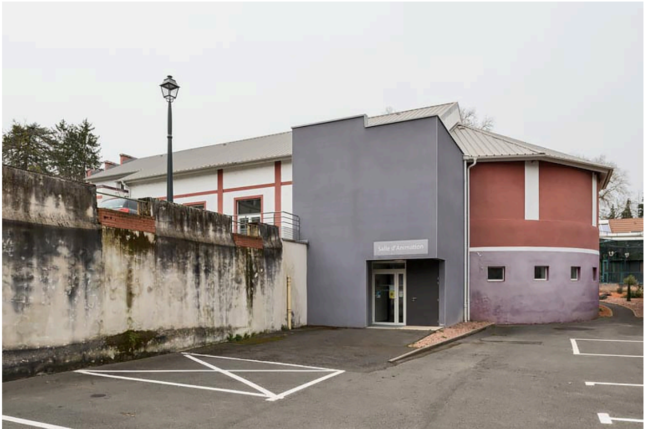
Abside de l'ancienne piscine, derrière le mur du fond de scène, vue depuis le sud-est.
