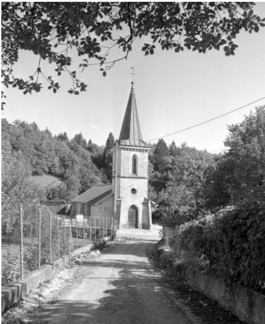
Extérieur : façade occidentale.
