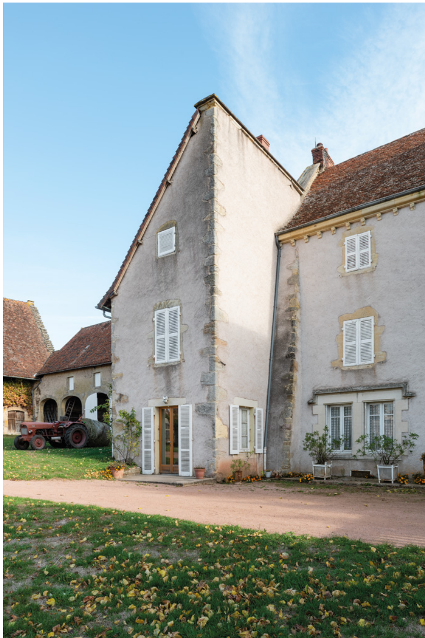
Aile nord et façade du logis.
