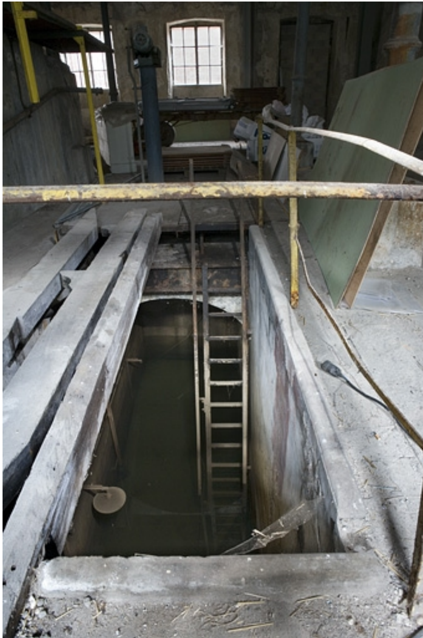
Atelier de préparation de la pâte. Citerne d'eau.
