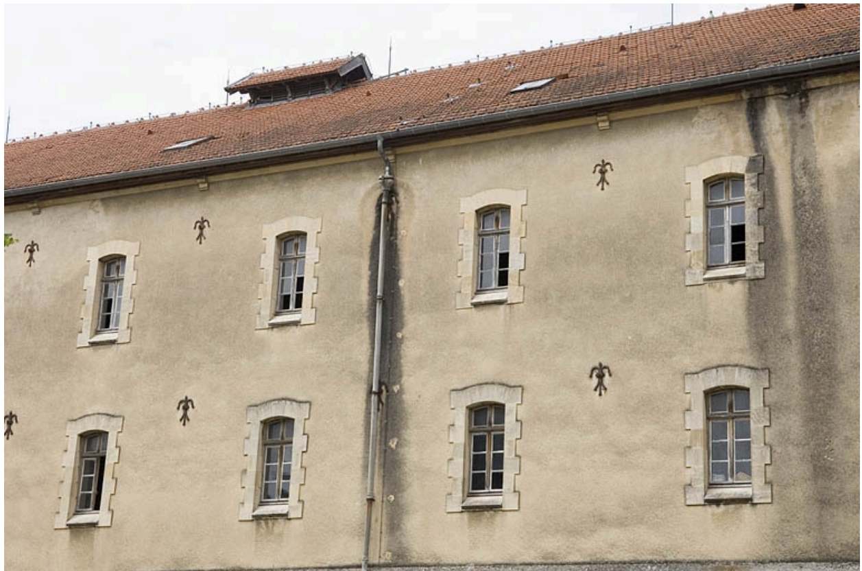
Etages supérieurs du corps central.
