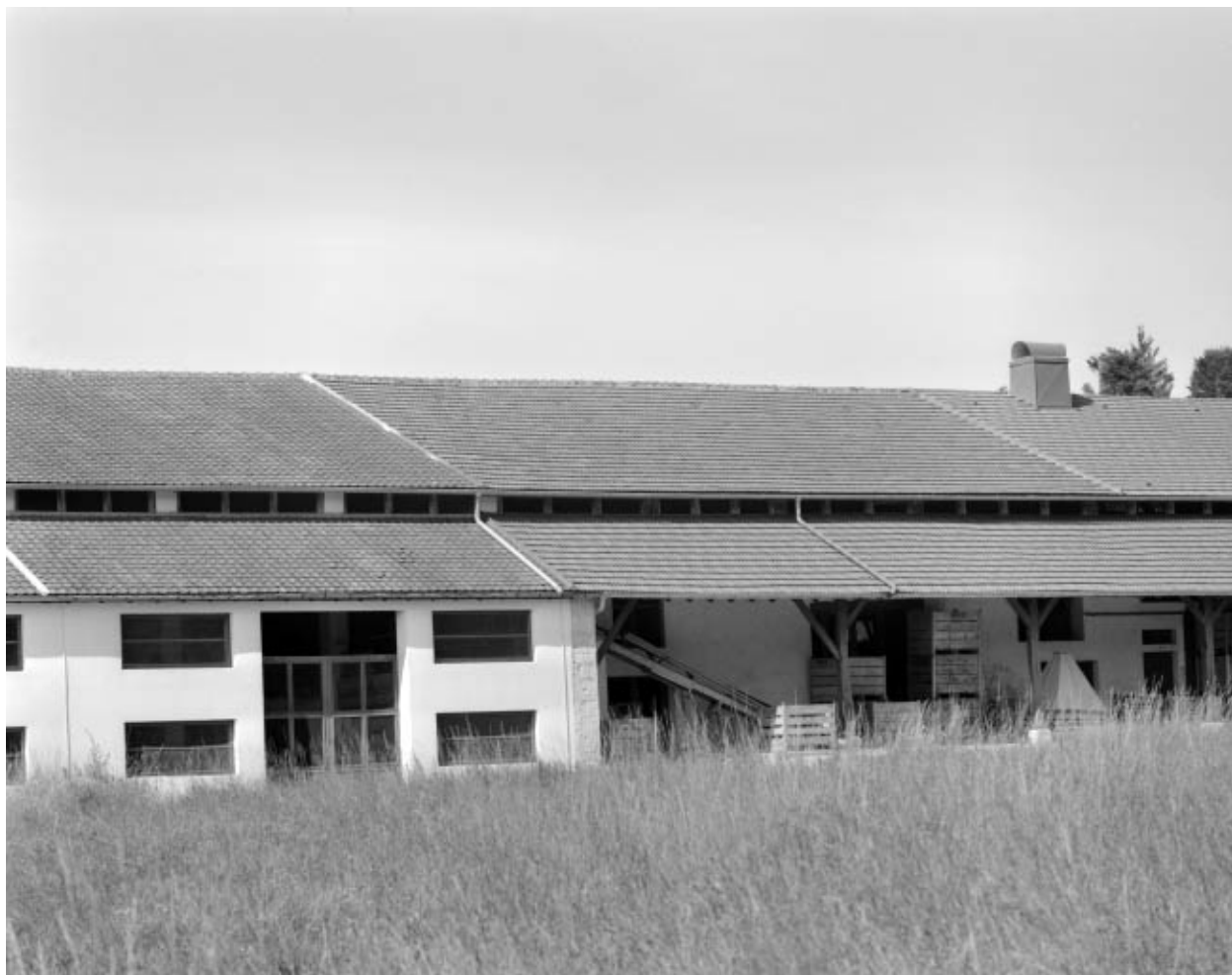
Séchoir : détail de la façade antérieure.
