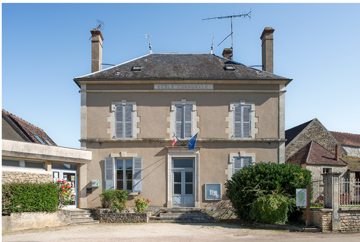
La façade principale sur la rue.
