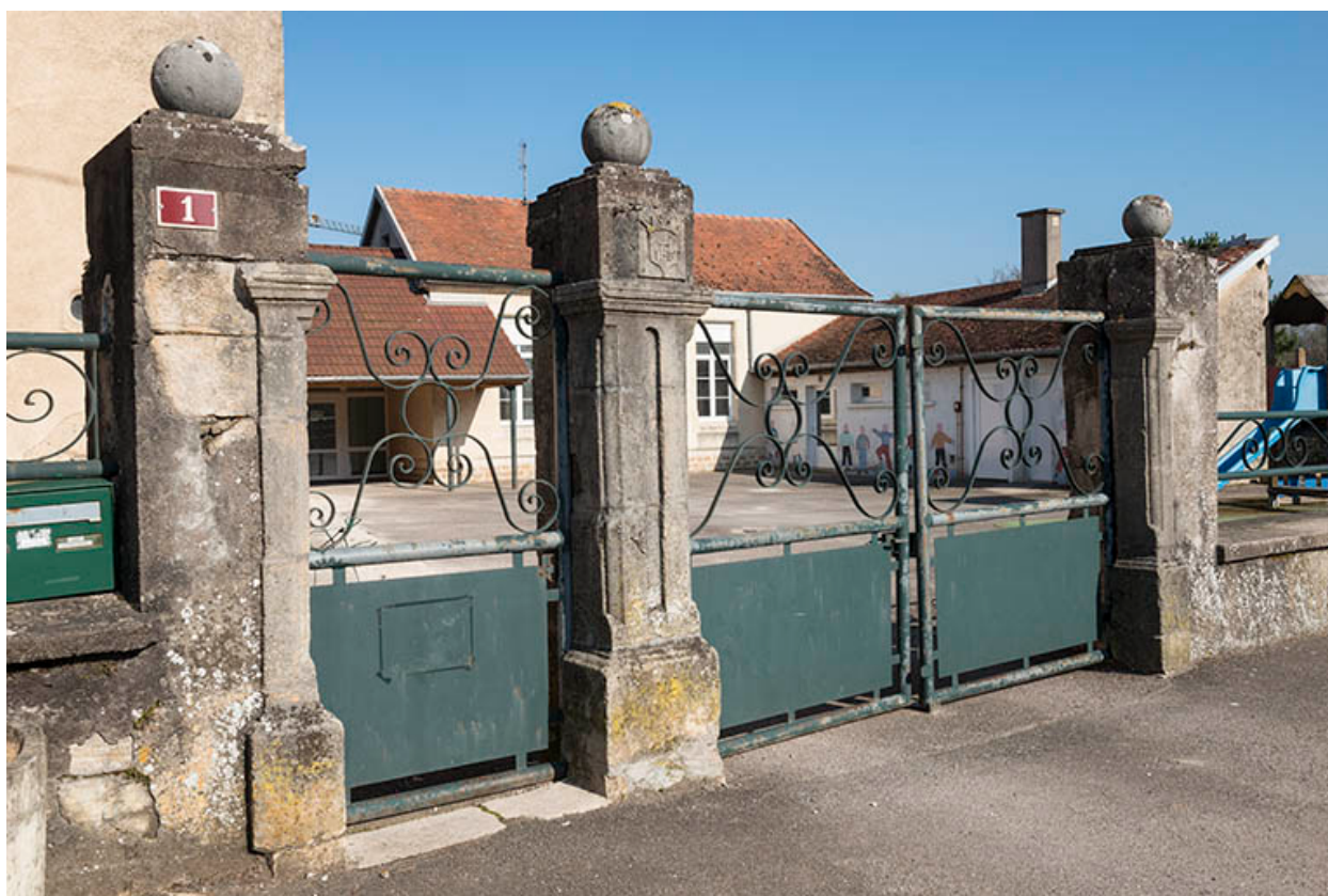
L'entrée depuis la rue.
