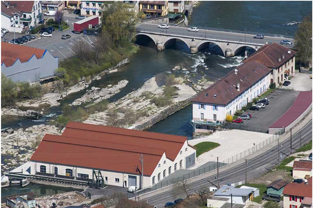
Bâtiments de bureaux en aval du site.
