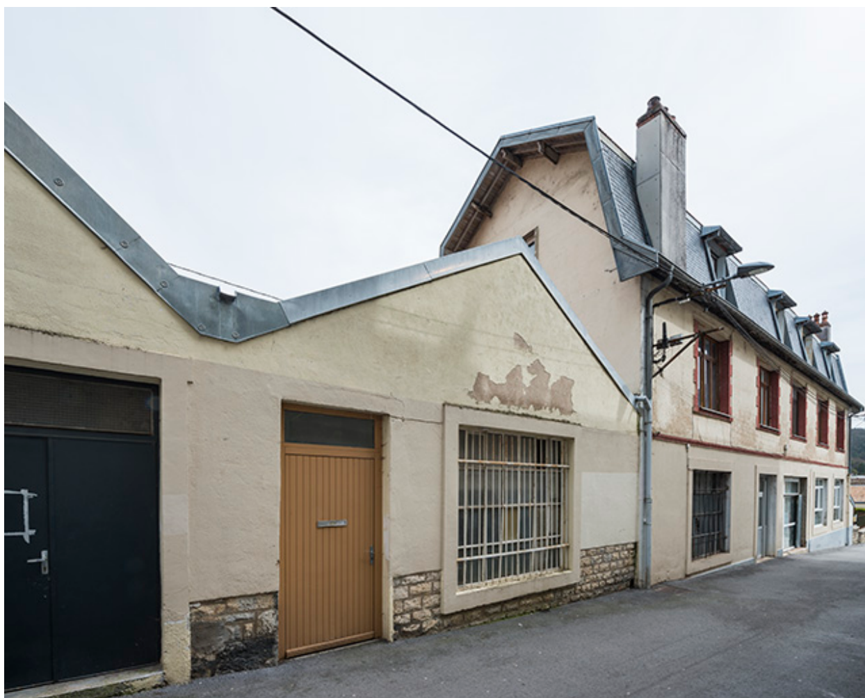
Atelier depuis le nord-ouest.
