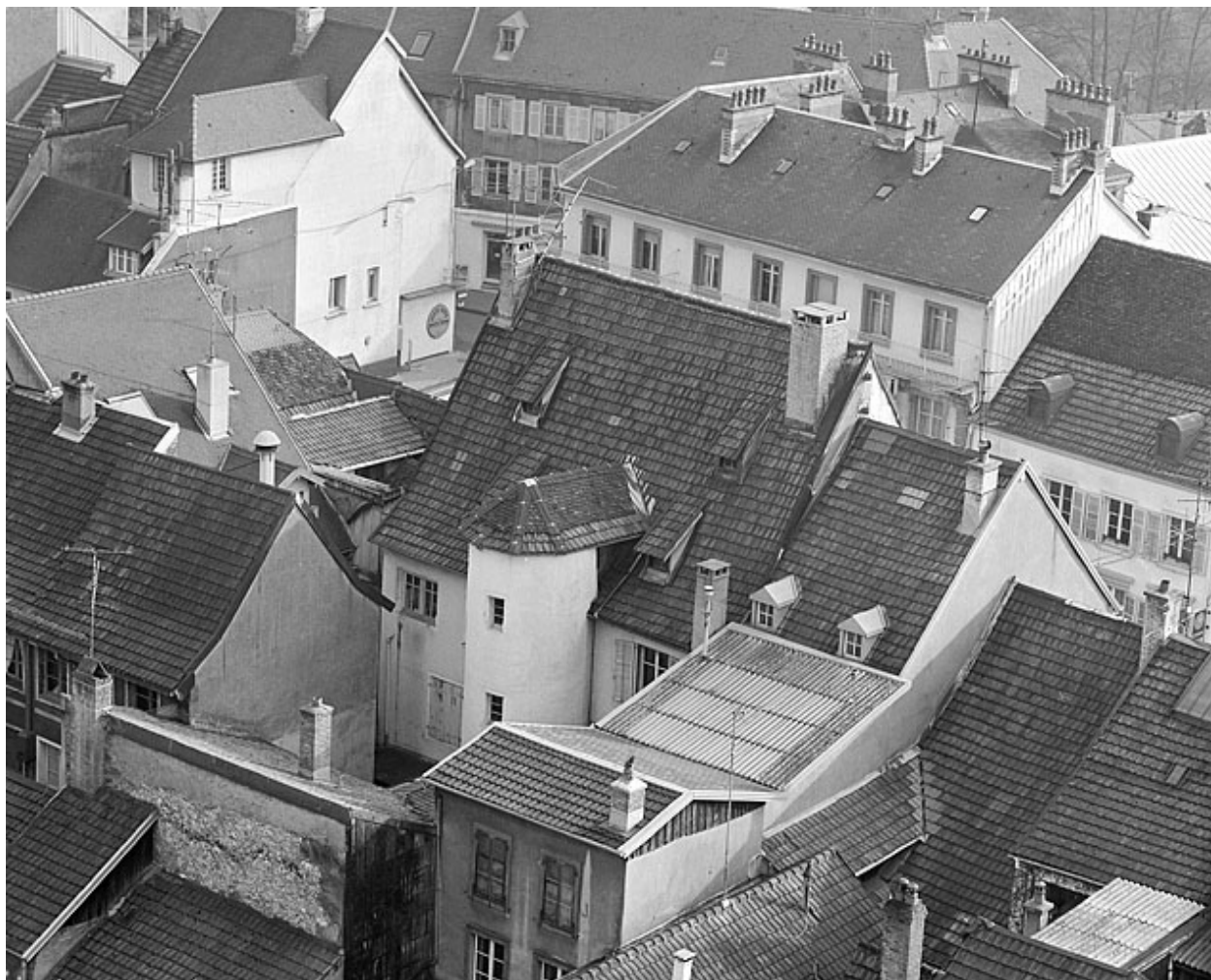
Vue d'ensemble des toitures.
