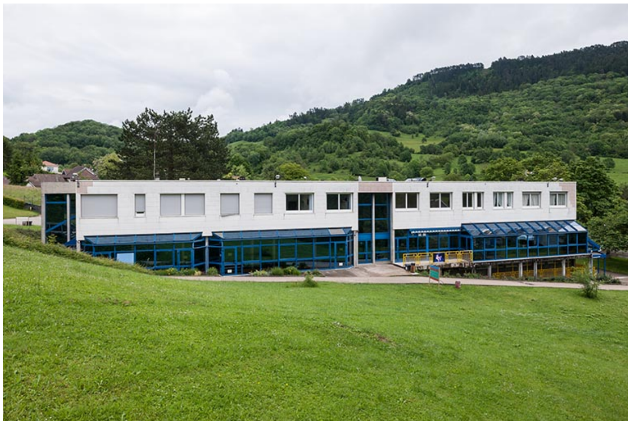
Façade antérieure occidentale de la restauration.
