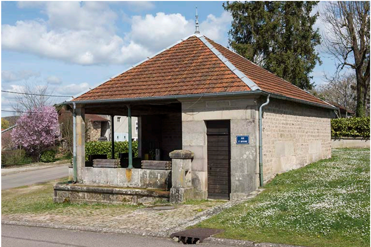
Fontaine-lavoir rue Saint Antoine : vue de trois-quart nord-est.
