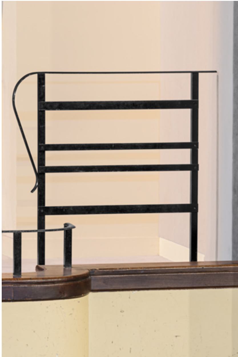
Salle, balcon : ferronnerie sur le garde-corps, côté jardin.
