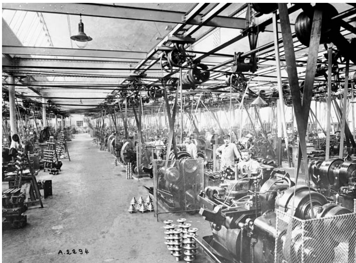
Usine d'Audincourt (?). Atelier de tournage de pièces. Photogr., s.n., s.d. [début 20e siècle].
