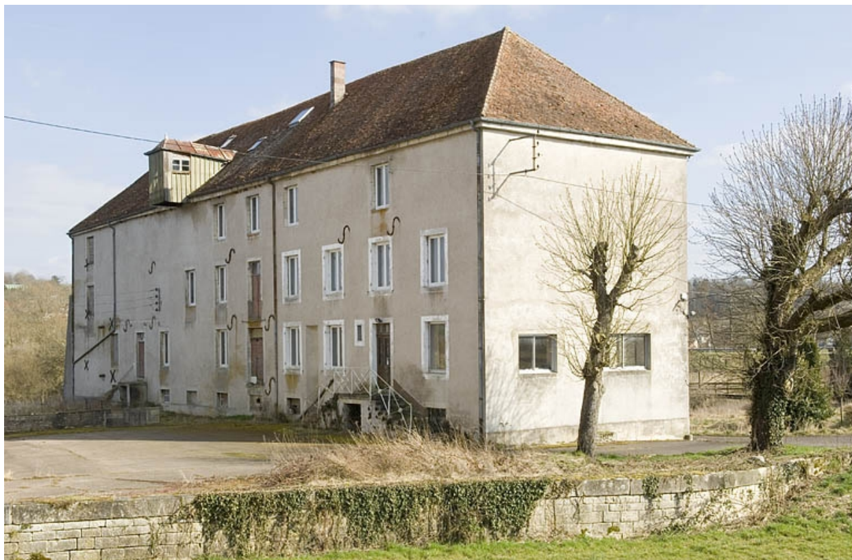
Façade nord vue de trois quarts.
