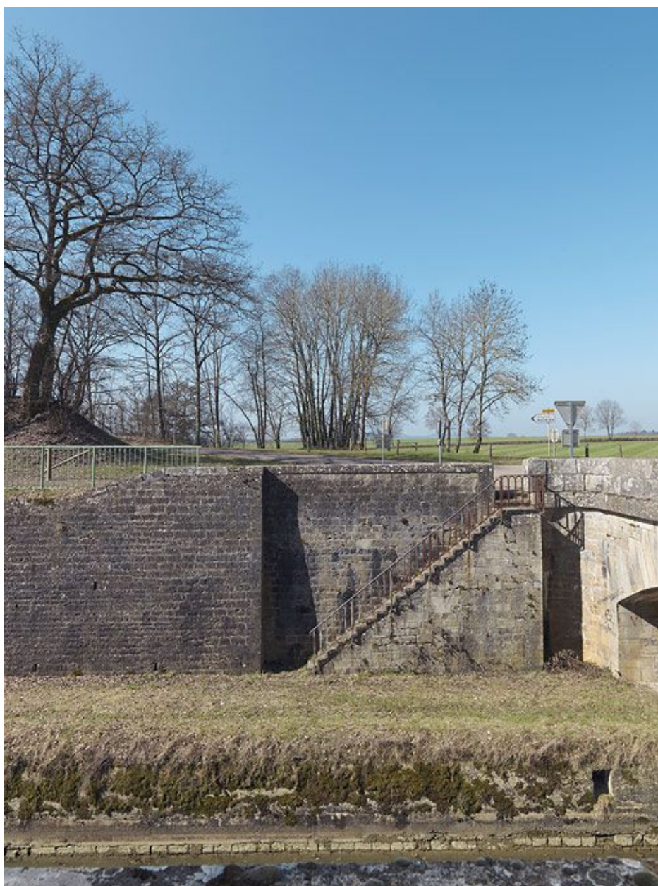
Escaliers d'accès au pont.
