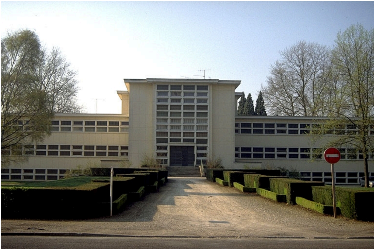
Façade antérieure, vue de face.
