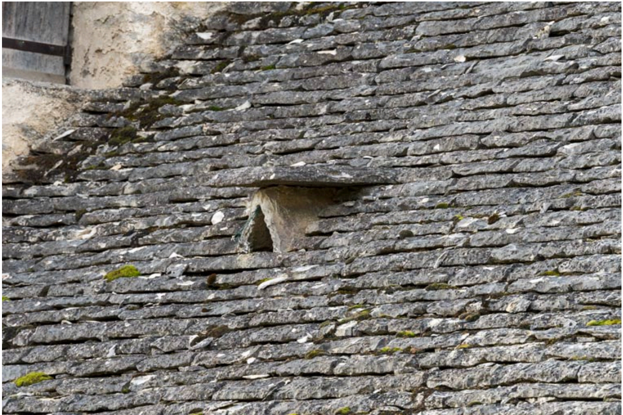
Détail de la toiture côté nord.
