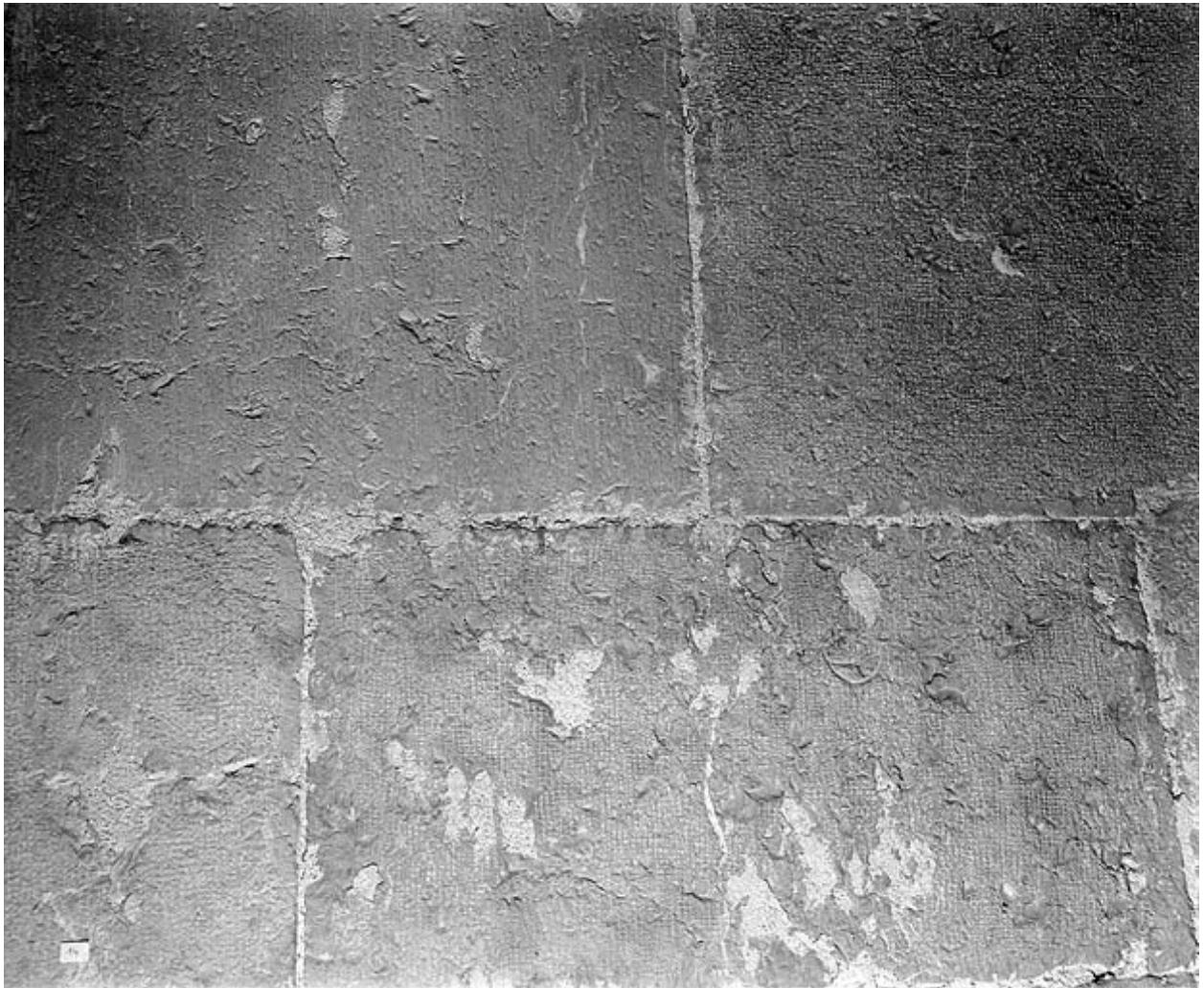
Détail du parement intérieur à l'extrémité orientale du collatéral sud (traces de boucharde et de laie).
