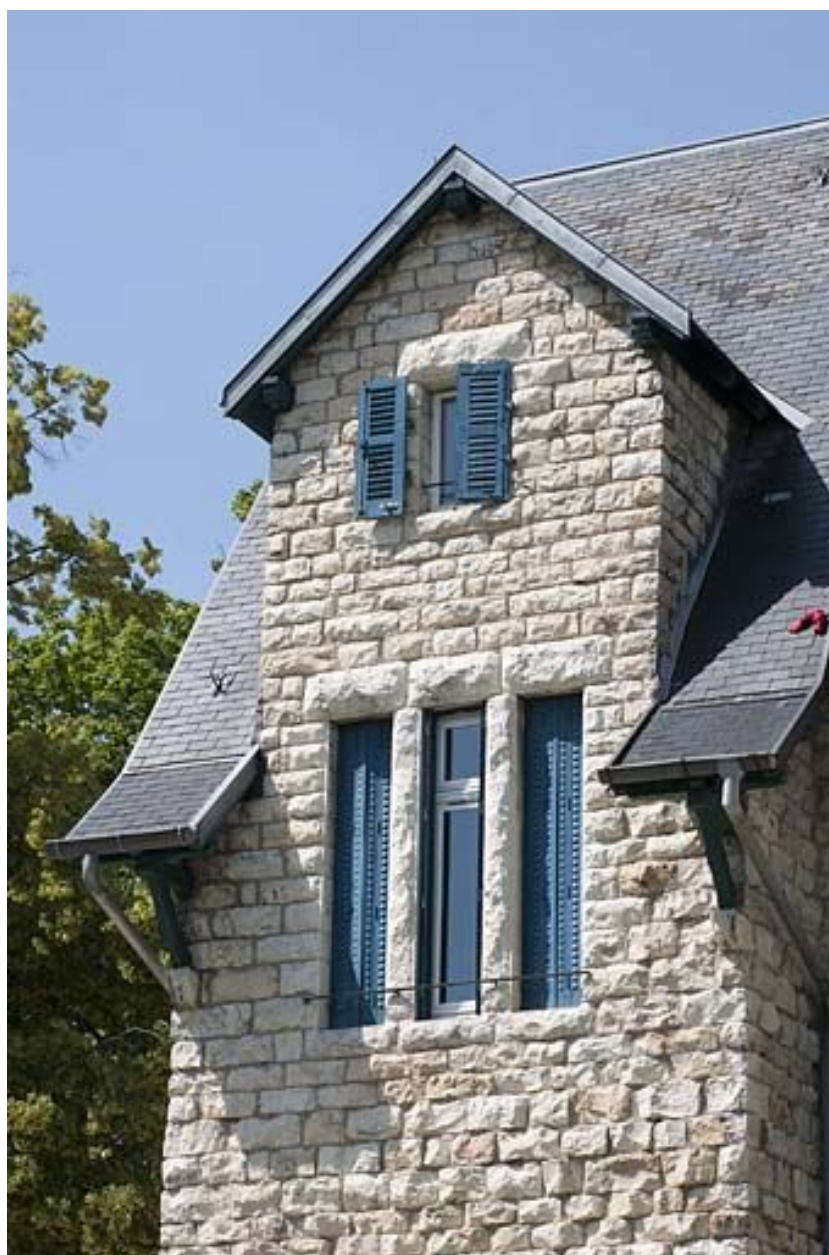
Façade postérieure. Pignon sud.
