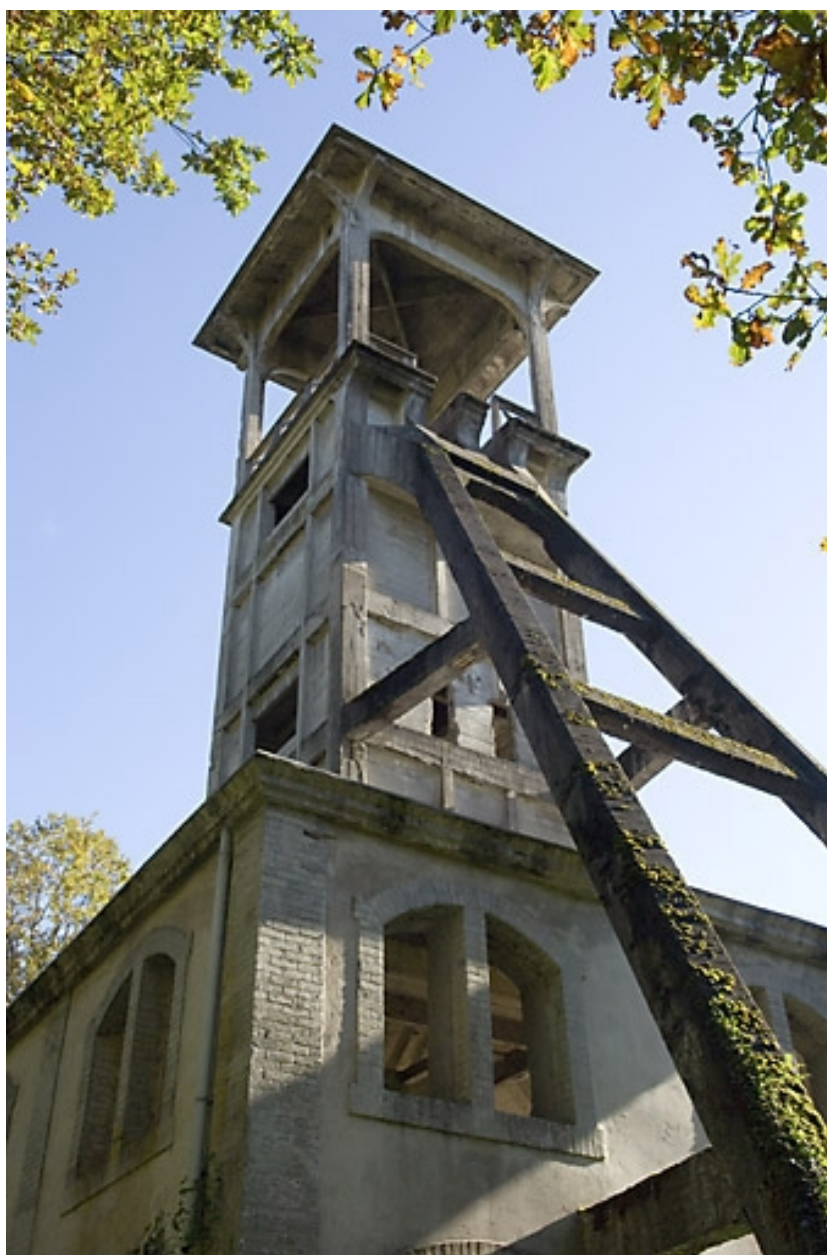
Le chevalement. Détail de la partie supérieure.
