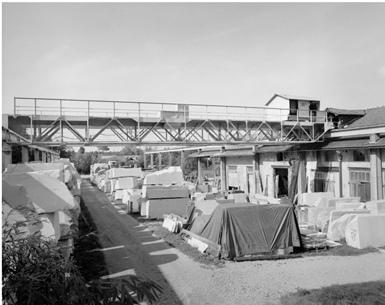
Atelier de fabrication et pont roulant.
