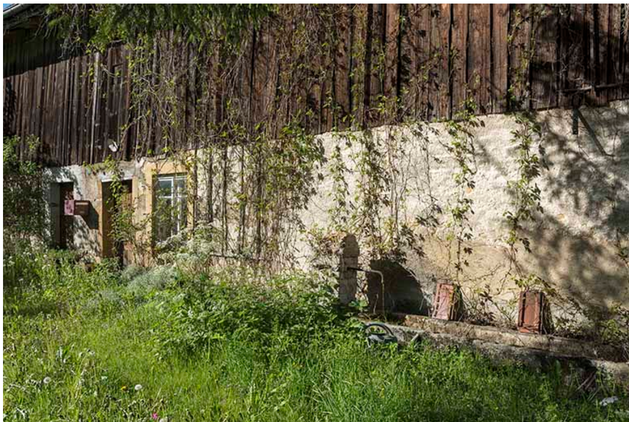
Façade latérale gauche, avec fontaine.
