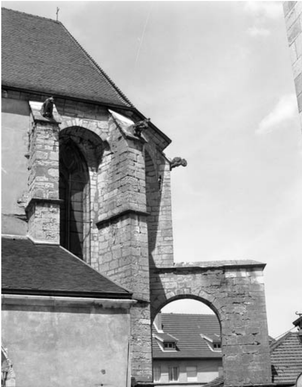
Chevet : détail des contreforts partie droite.
