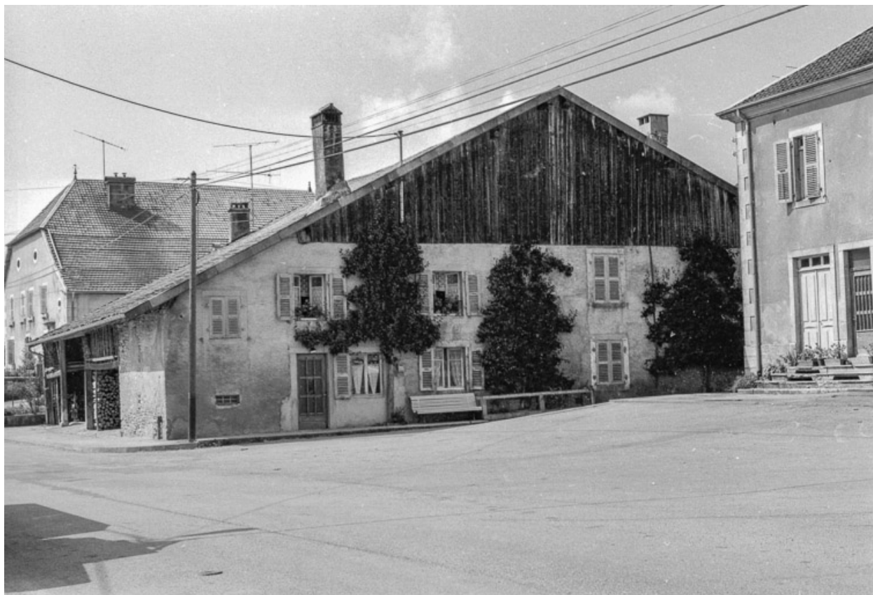
Façades antérieure et latérale droite.
