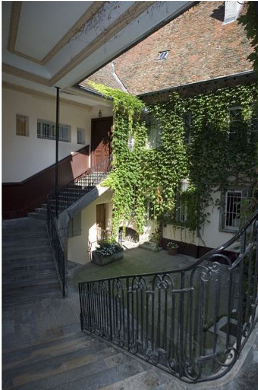
Vue de la cour depuis l'escalier à cage ouverte.
