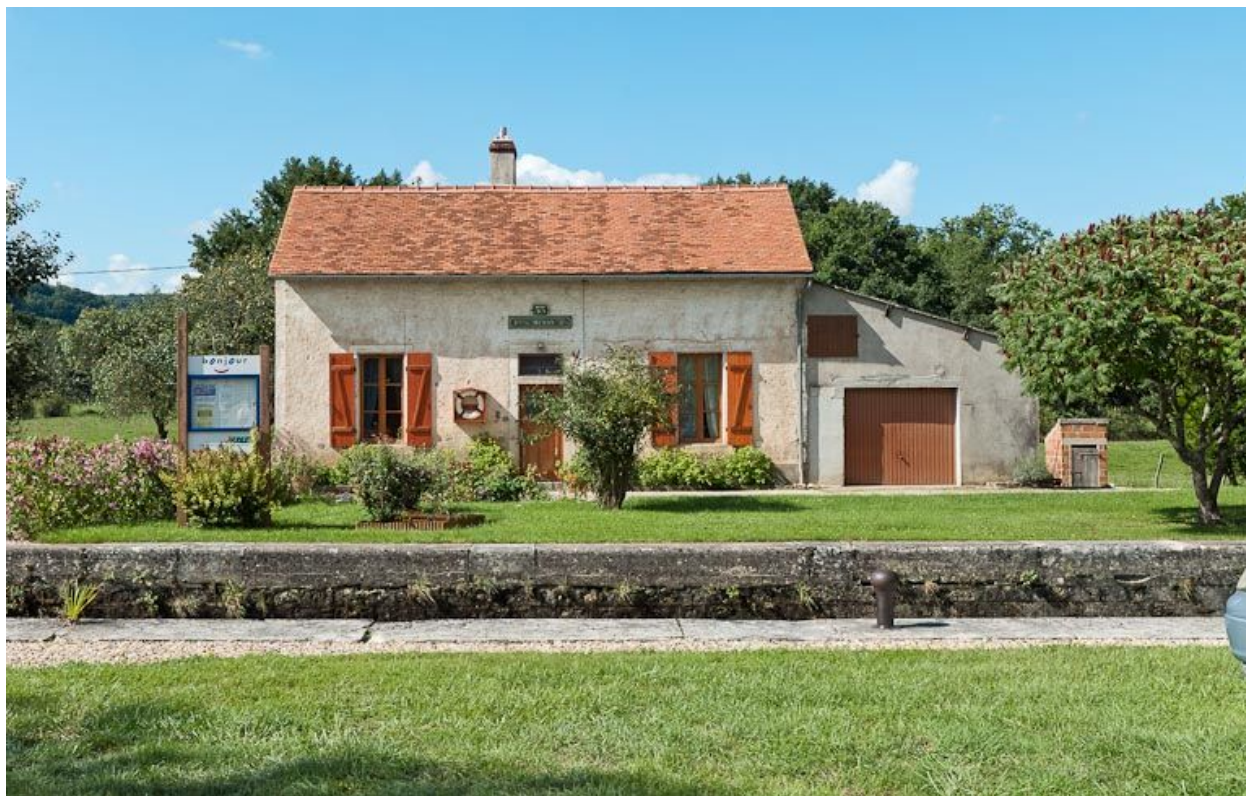
Vue de face de la maison éclésièr.
