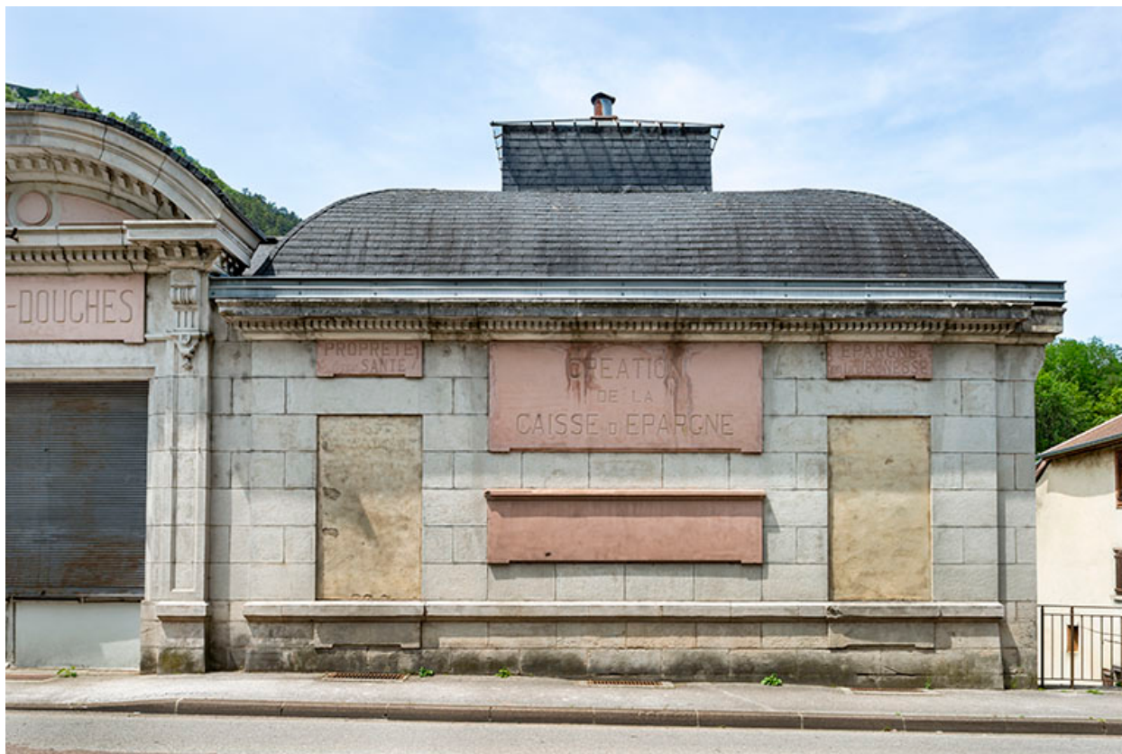
Elévation sur rue du pavillon nord.
