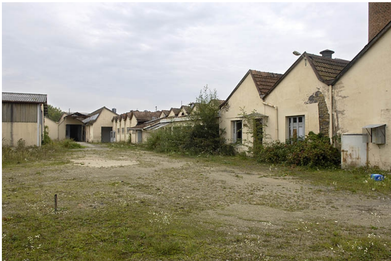
Murs-pignons nord de la salle de tissage.
