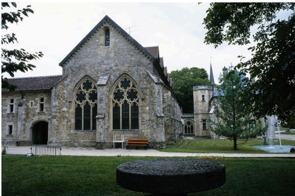
Bâtiment du réfectoire, élévation sud.
