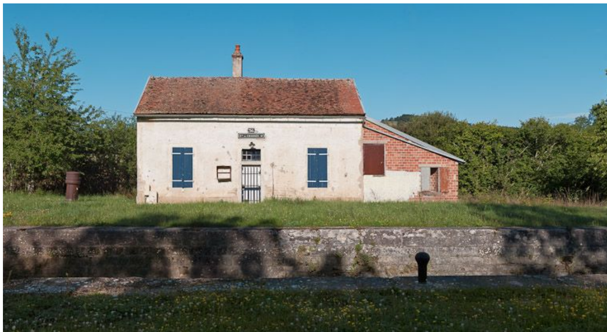
Vue de face de la maison éclusière.
