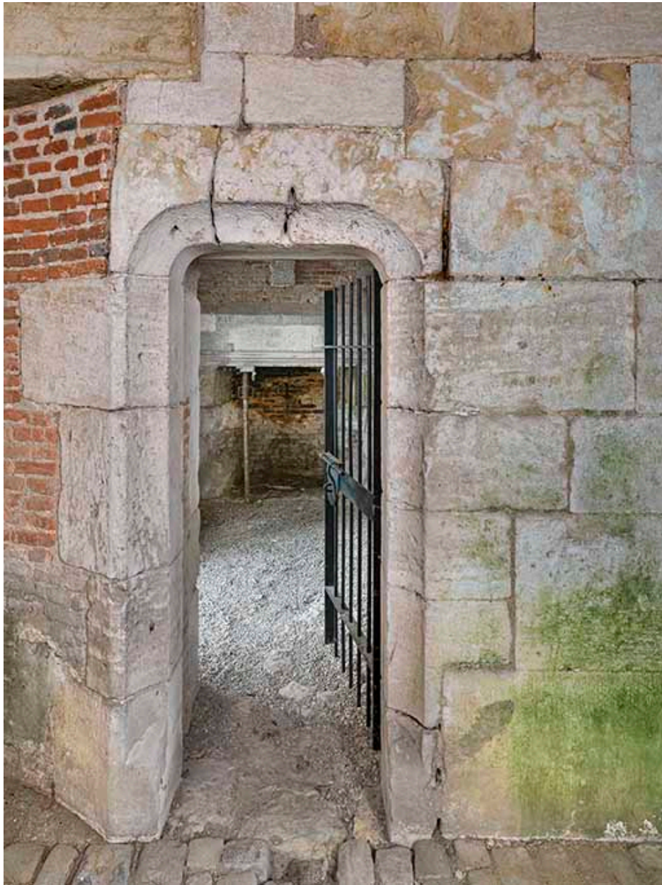
Pavillon d'entrée : entrée du corps de garde.
