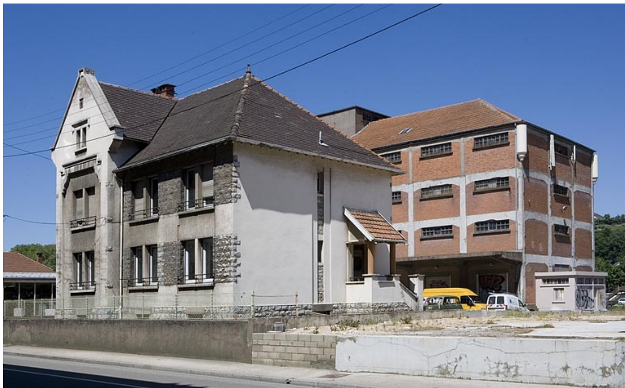
Bureau : façade antérieure de trois quarts droite.
